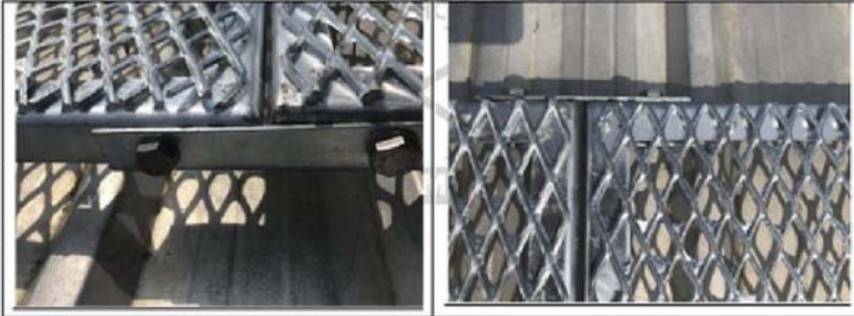
การยึดติดตั้ง ตะแกรงทางเดินโซลาร์เซลล์ XS43
